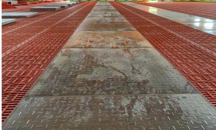
La **PURITERMIA** es la tecnología que aprovecha el calor del purín para calefacción mediante placas hidráulicas o suelo radiante.
