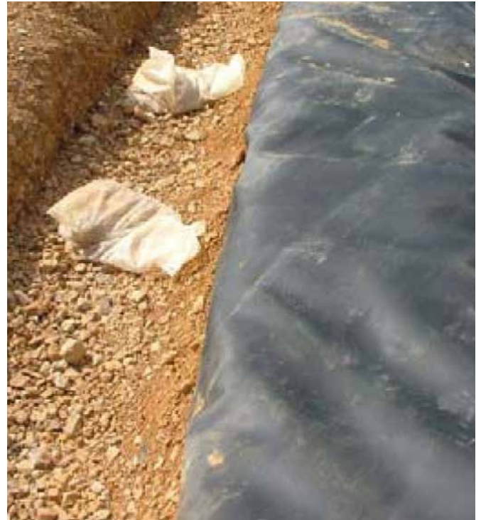
Zanja de anclaje
