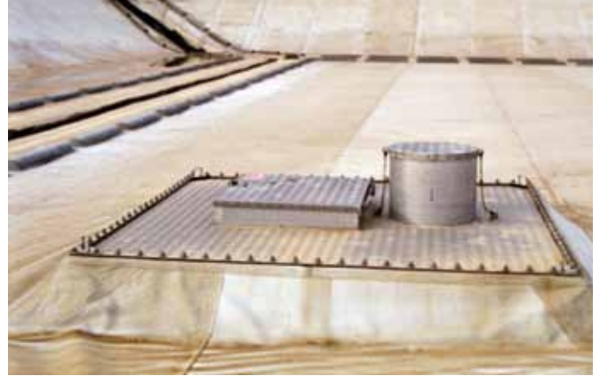
Bocas de registro
