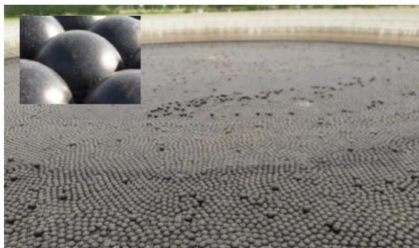
Figura 2. Depósito con piezas sintéticas esféricas (Fuente: Panal Flotante, SL)
