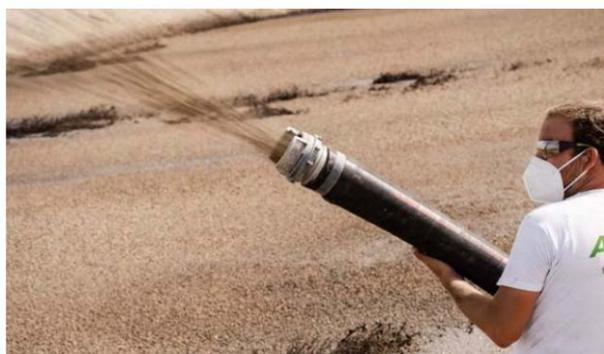
Figura 4. Instalación de arcillas expandidas mediante cisterna (Fuente: ARVET, SL)
