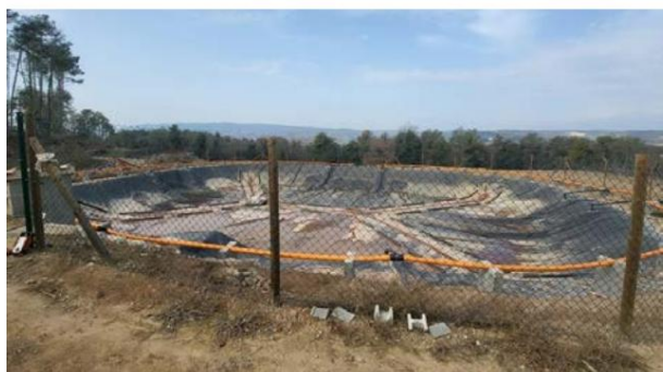
Figura 4. Balsa de geomembrana con cubierta flotante. Fuente: IRTA
