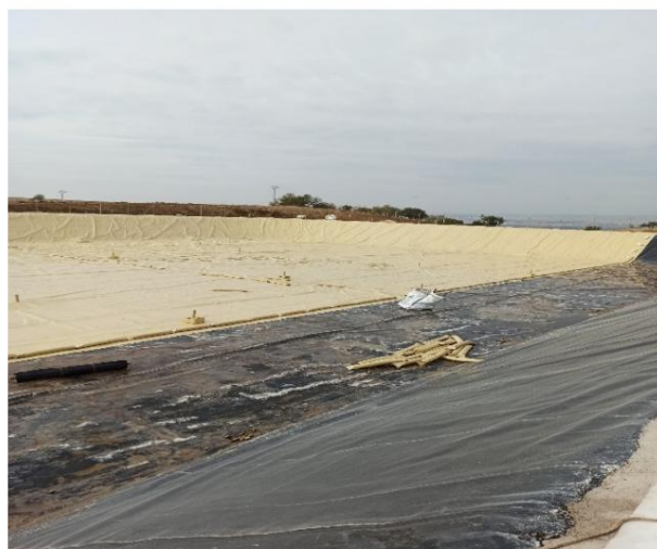
Figura 8. Vista general y de instalación de lámina flotante en balsa. Fuente:DACC
