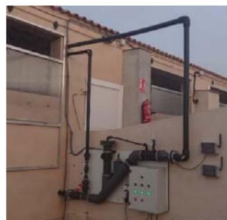
Figura 8. Sistema de dosificación de ácido con recirculación de los purines en el interior de la nave. Fuente: Fertinagro Biotech, SL.
