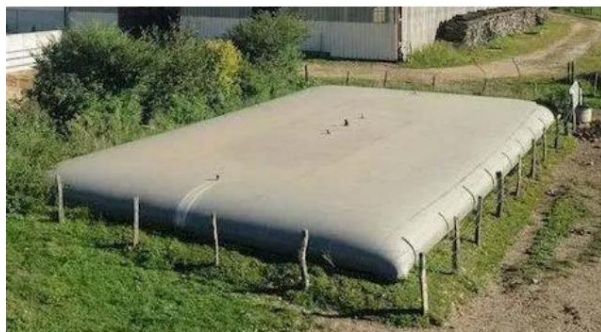
Figura 3. Imagen de una bolsa o cisterna de purinas flexible. Fuente: Nutriset SL – Labaronne.
