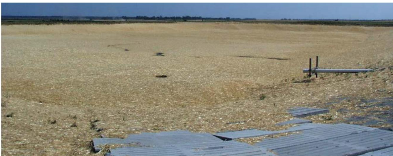
Figura 3. Imagen de balsa con cubierta de paja. Fuente: Universidad de Iowa (Review of permeable cover options for manure storage)
