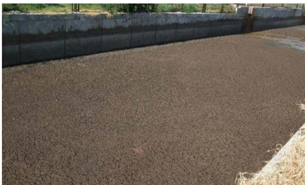
Figura 2. Imagen de depósito con costra natural. Fuente: DACC
